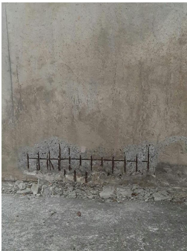
Défaut d'enrobage d'un voile semi-enterré niveau R-2 dans un ERP
