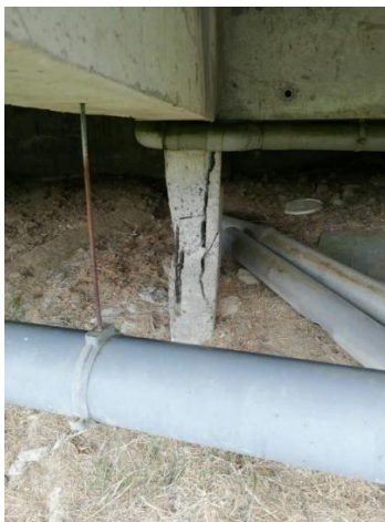
Dégradation alarmante d'un poteau en béton armé situé en soubassement d'un immeuble R+4
